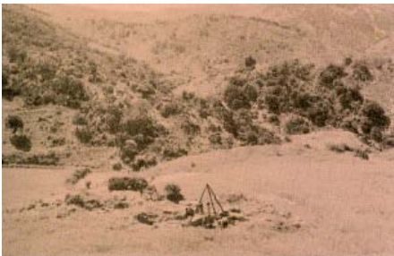
Antas. Il tempio durante i lavori preliminari
