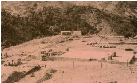
Antas. Il tempio romano visto da Nord durante i lavori di scavo e restauro.
