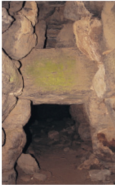
Fig. 362. Bortigali, Nuraghe Orolo: ingresso con architrave e finestrino di scarico del mastio.
