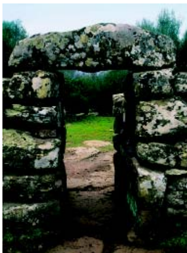
Recinto A: particolare dell'ingresso.
