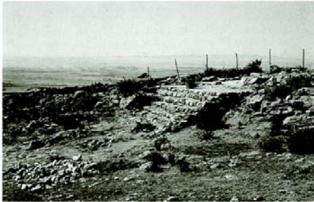
Fig. 3. Monte Sirai. L'area del tofet durante i lavori del 1964.
